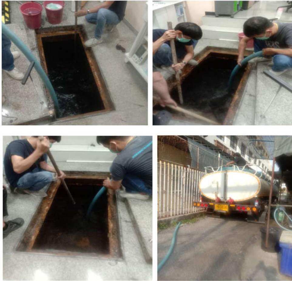
ภาพที่ 2 การสูบกากบ่อเกรอะ อาคาร 1
